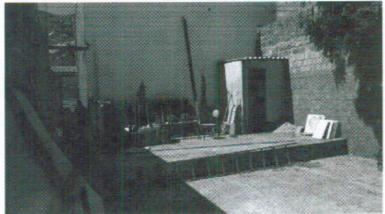
Imagem setor do deposito – foto 8/9
